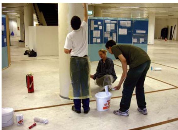
Studentische Mitarbeiter während der Renovierungs- und Aufbauarbeiten
